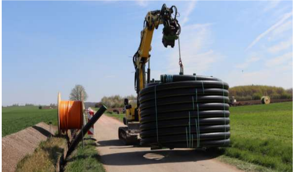
Grabenfräse + Verlegung der Wärmerohre
