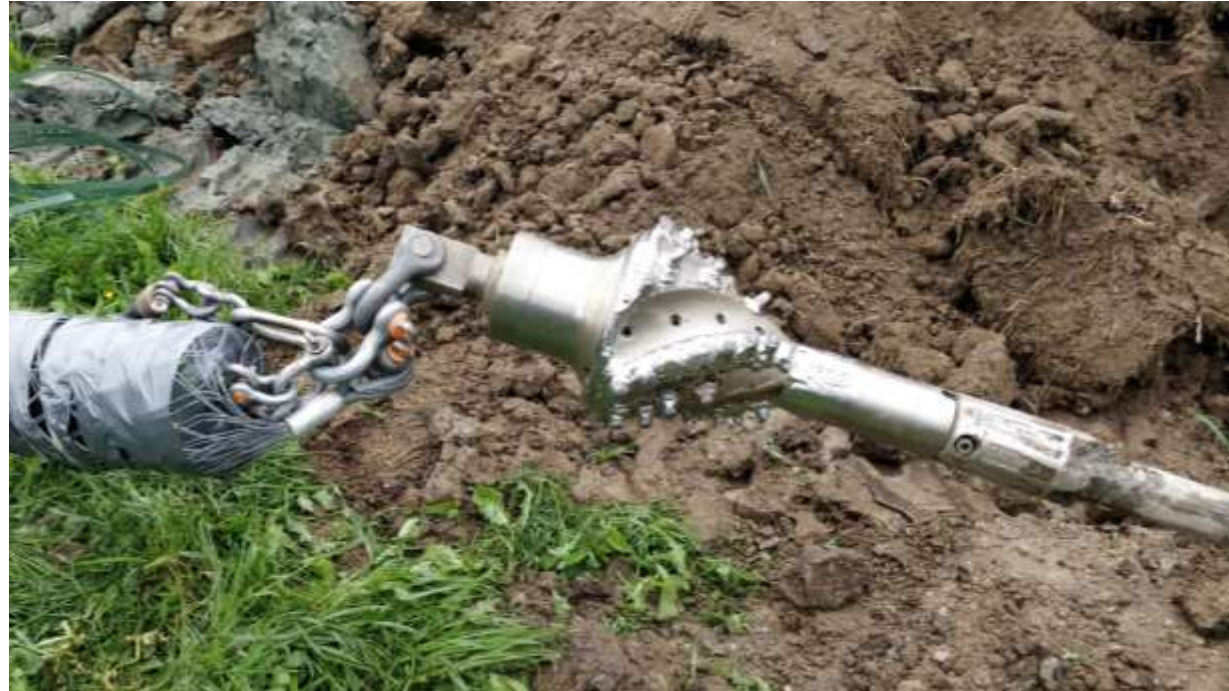
Grabenlose Verlegung im günstigen Spülbohrverfahren
