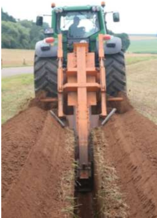
Grabenfräse + Verlegung der Wärmerohre
