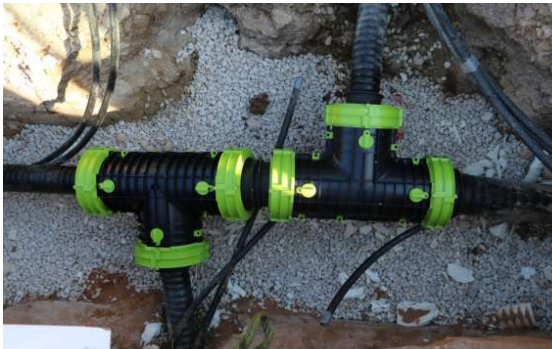
T-Stück im offenen Graben
