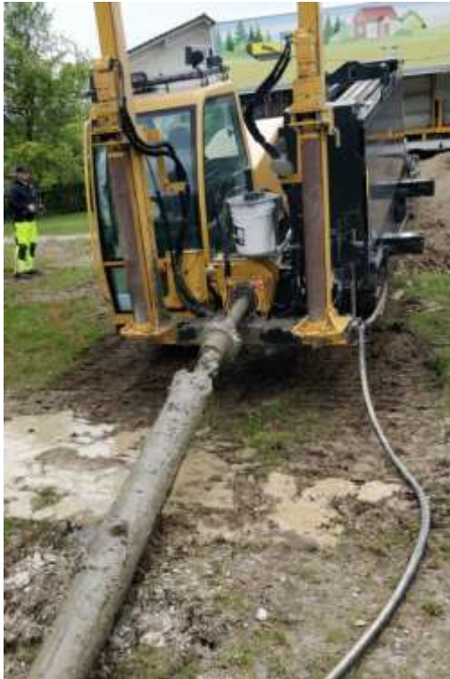
Grabenlose Verlegung im günstigen Spülbohrverfahren
